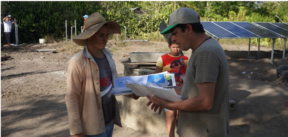
Formación en apoyo a la instalación de los Sistemas Fotovoltaicos Autónomos (SFVA) en la comunidad Ensenada del Indio, municipio Río Cauto - Granma.
