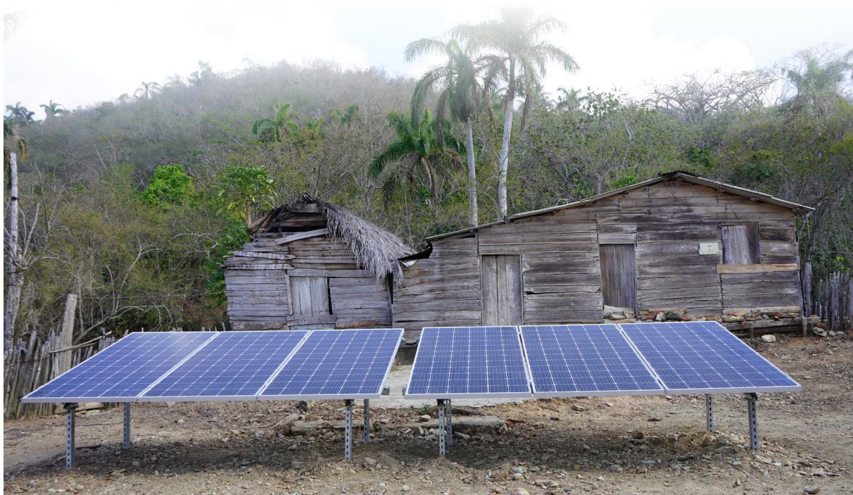
Instalación de los Sistemas Fotovoltaicos Autónomos (SFVA) en la comunidad Palenque, municipio Imías - Guantánamo.
