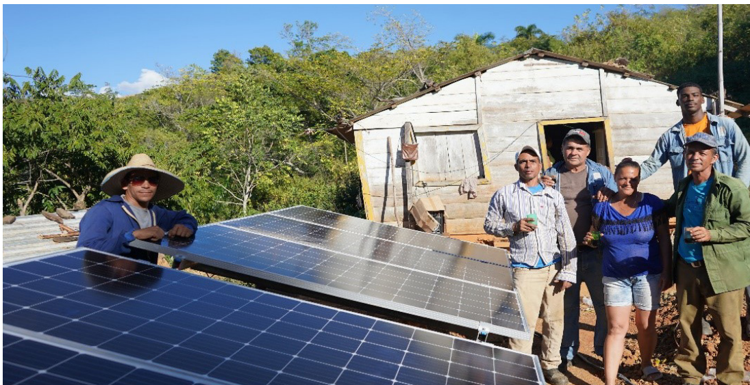
Instalación de los Sistemas Fotovoltaicos Autónomos (SFVA), municipio Imías– Guantánamo.
