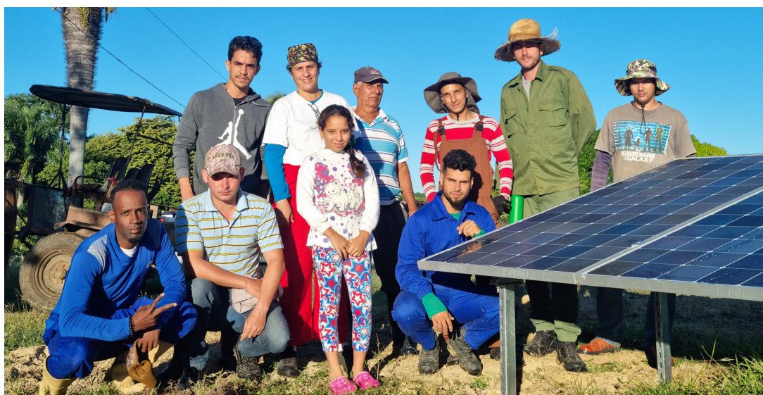
Instalación de los Sistemas Fotovoltaicos Autónomos en la comunidad Los Alazanes, municipio Sancti Spíritus - Santi Spíritus.
