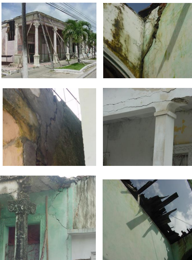
2.F.4 Lesiones típicas de las viviendas del centro tradicional.
