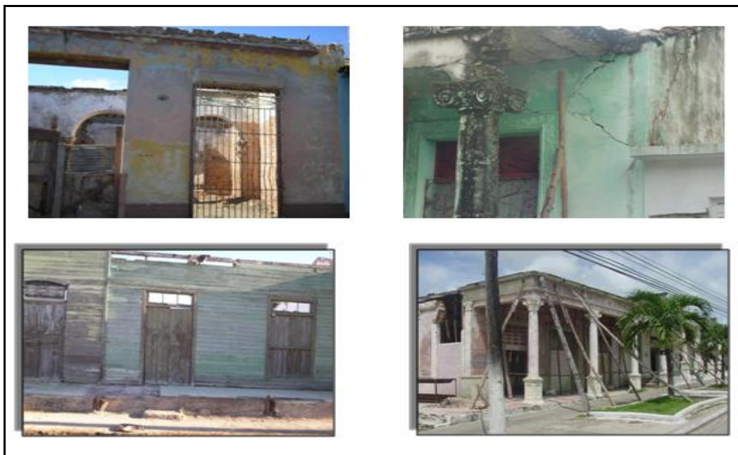
2. F.2 Lesiones típicas de las viviendas de los centros tradicionales de ciudades intermedias de Sancti Spíritus.
