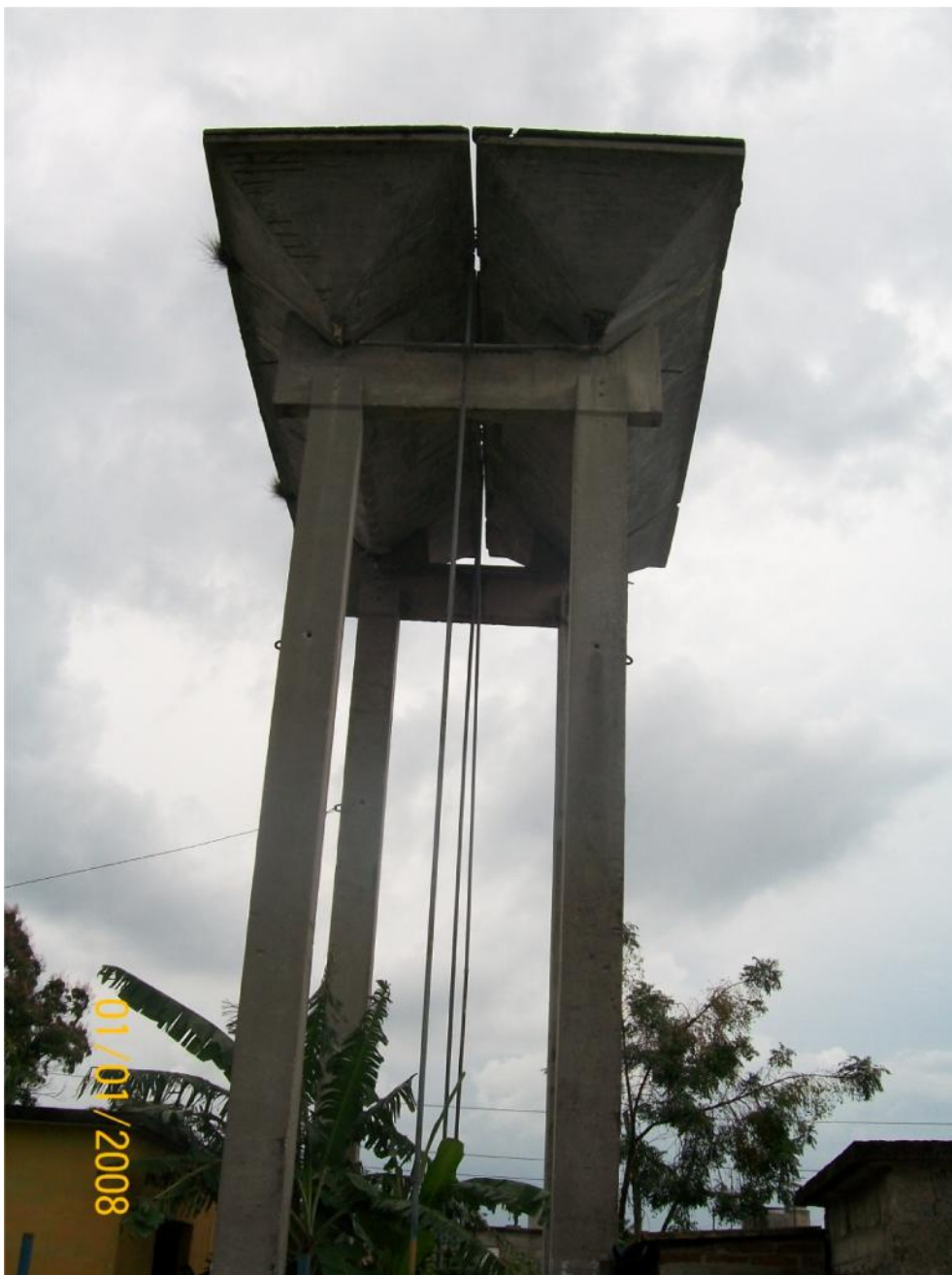
Anexo 21: Tanque de agua, inicio de la calle Cuba
