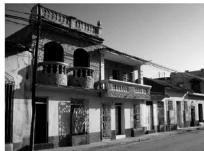
Casas en la calle Camilo Cienfuegos que presentan modificaciones en las fachadas.
