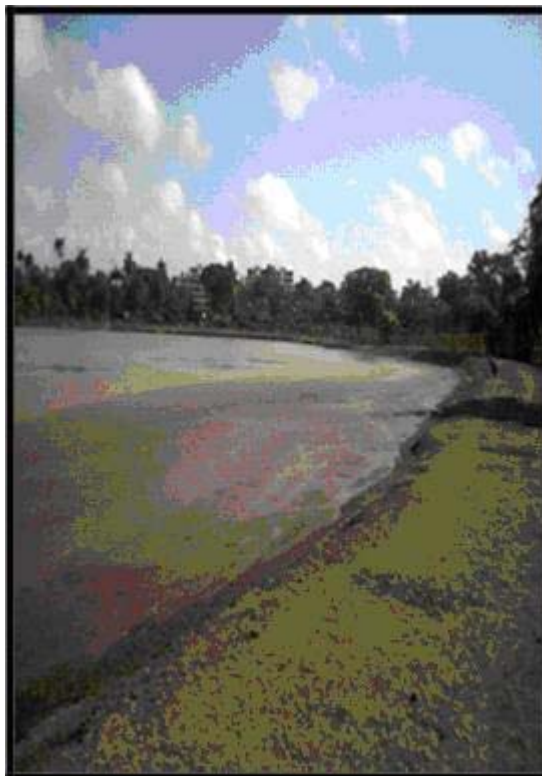
3. Sistema de tratamiento de residuales Empresa Azucarera "M. Hernández" Destilería anexa Mayo 21/2004. Yordanis G. Puerta de Armas
