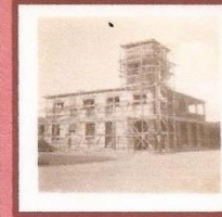
La Iglesia en su etapa de reconstrucción y remodelación en 1956.
