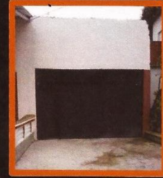
Parte frontal de la casa culto de la Iglesia Bethel.
