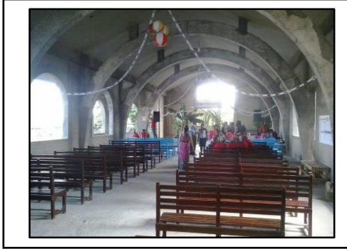
Foto 7: Imagen del salón de culto, segundo piso del templo.
