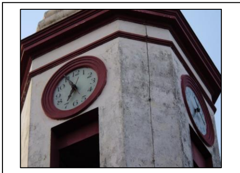
Foto 16: Imagen de los relojes en la torre del campanario.
