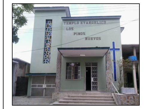
Foto 2: Imagen exterior de la Iglesia Los Pinos Nuevos construida en 1994.
