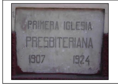
Foto 15: Imagen de la placa conmemorativa de las fechas de construcción de los dos templos que ha tenido la Iglesia Presbiteriana-Reformada en Cabaiguán.
